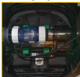
Rückschlagventil und Schmutzwasserpumpe Mach II
